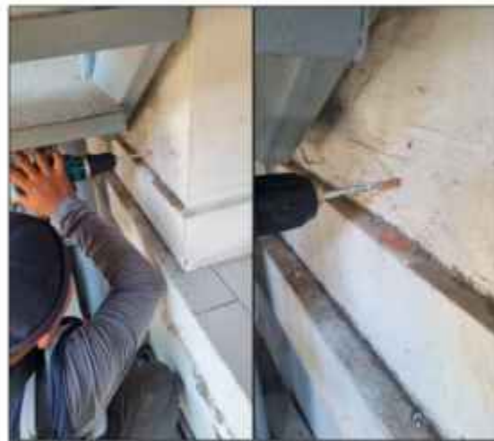
Gambar 3. 17 Kondisi Kolom dan Dinding Bangunan Gedung NIAS
