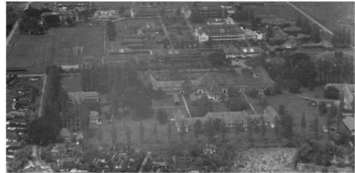
Gambar 3. 10 Aerial View Gedung NIAS dilihat dari sisi utara (1)
